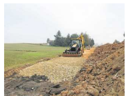
Droga w Wolbromiu w trakcie prac
