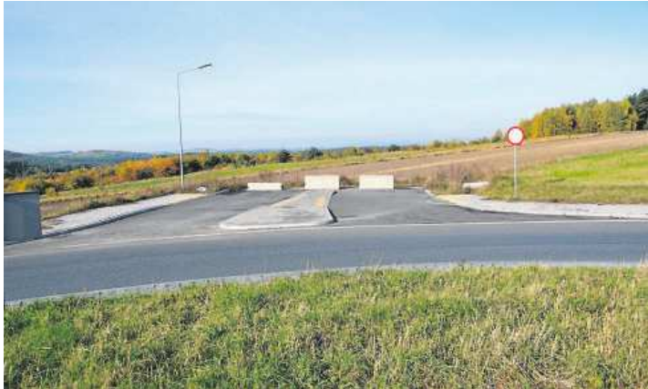
Tu rozpocznie się budowa III etapu obwodnicy
